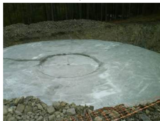
Fotografia 2.11 – Betão de limpeza
