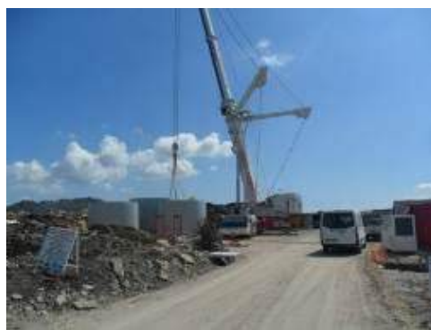
Fotografia 2.18 – Montagem da torre
