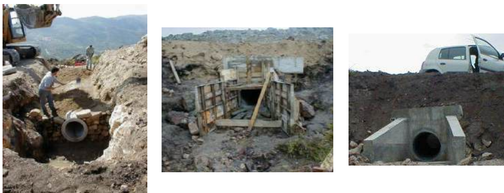
Fotografias 2.4, 2.5 e 2.6 – Construção de uma passagem hidráulica
