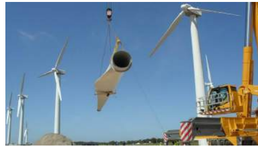
Fotografia 2.20 – Montagem de pás
