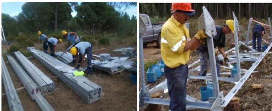
Fotografia 2.22 – Preparação da montagem da estrutura dos apoios
