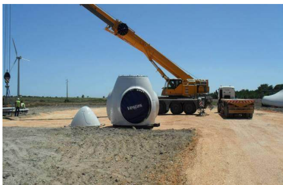
Fotografia 2.17 – Plataforma de montagem
