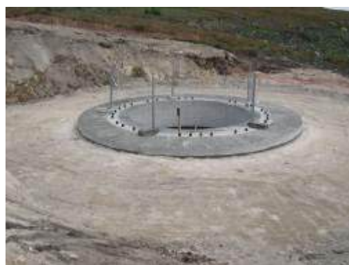
Fotografia 2.13 – Fundação aterrada
