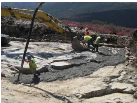
Fotografia 2.10 – Betonagem do betão de limpeza da fundação
