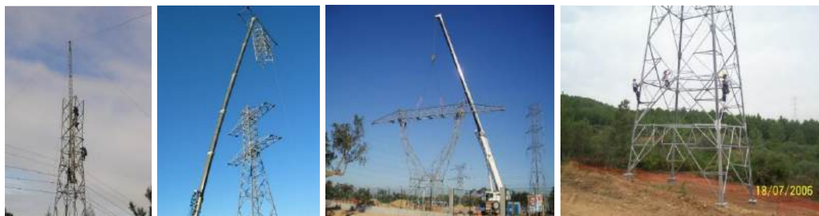
Fotografia 2.23 - Montagem da estrutura dos apoios
