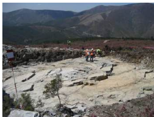
Fotografia 2.9 – Cabouco após escavação e limpeza
