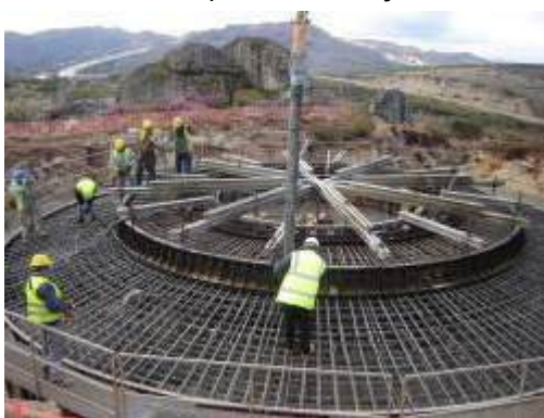
Fotografia 2.12 – Armação do aço
