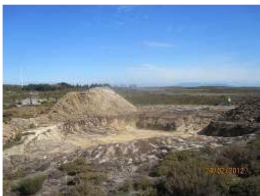
Fotografia 2.8 – Escavação do cabouco
