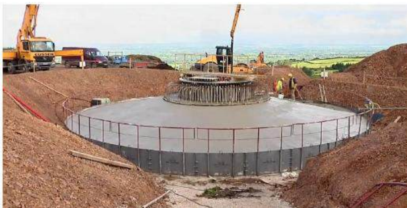
Fotografia 2.7 – Exemplo de uma fundação do aerogerador
