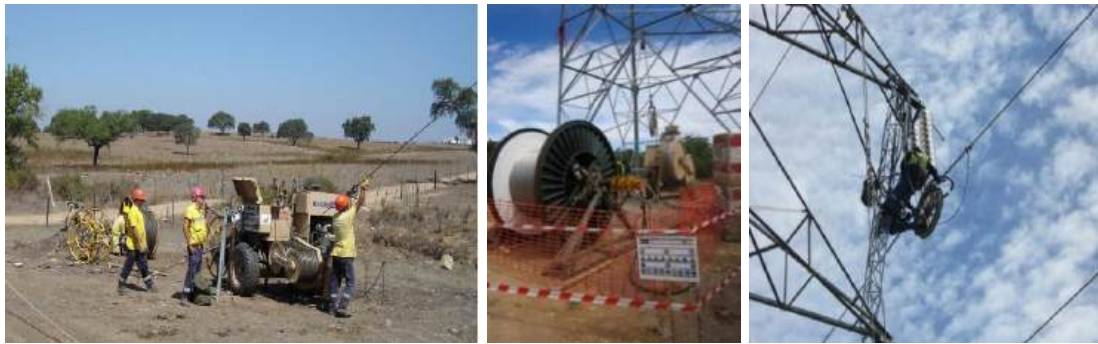
Fotografia 2.24 - Colocação dos cabos
